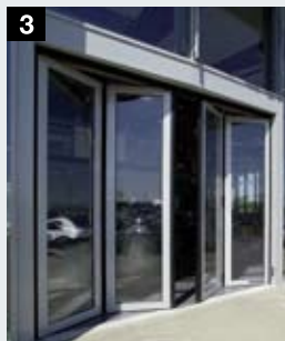
3 Skládací vrata z oceli a hliníku
